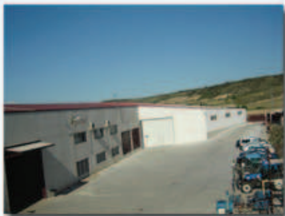
Vista general de las instalaciones
